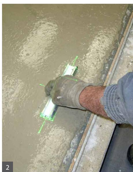
Projection du contour supérieur pour l'alignement exact du coffrage
